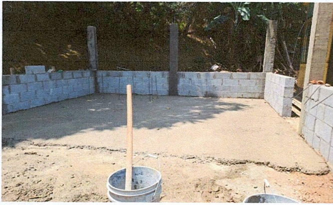
Foto 1: Cocina en construcción
