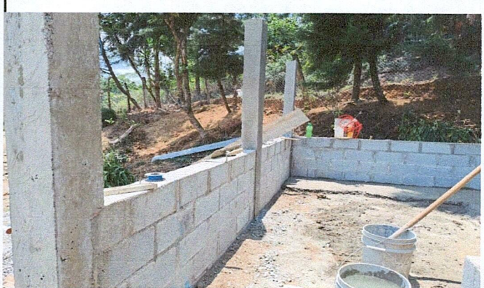
Foto 2: Colocación de piso de cocina.
